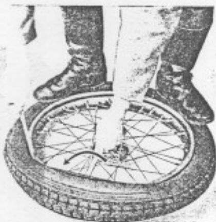
Bild 198. Hereinheben des letzten Stückes Deckenrand in die Felge. Gegenüberliegende Seite der Decke gut in das Tiefbett drücken
